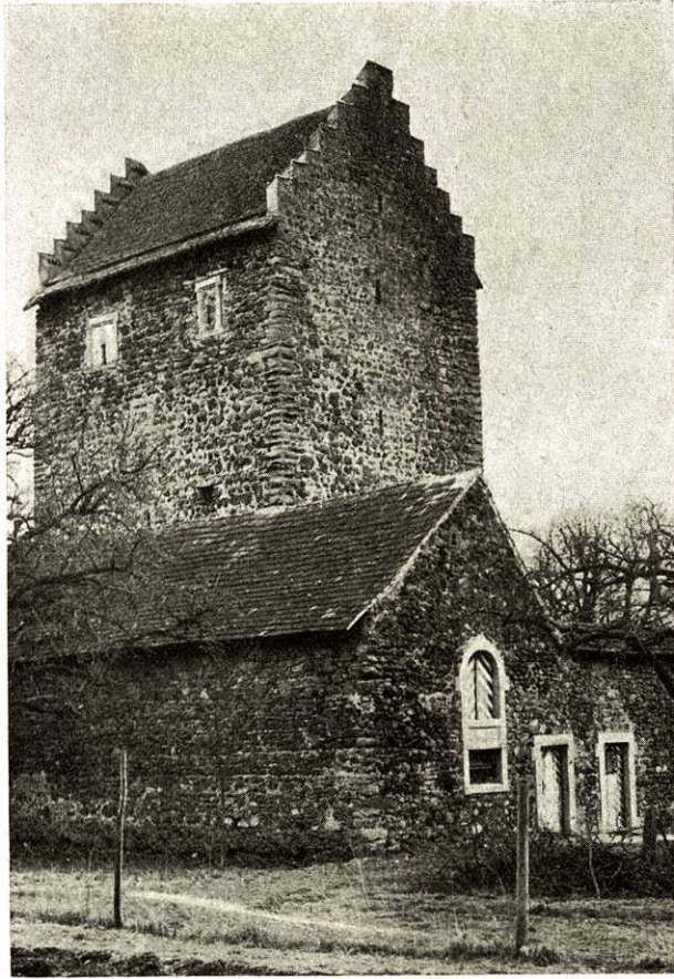
Riedheimer Wohnturm. - Älteste Teile aus dem 12. Jahrh., die interessante Dachgebälk-Konstruktion leider verschwunden
