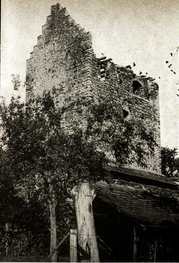
Ruine des Burgstalls zu Riedheim
