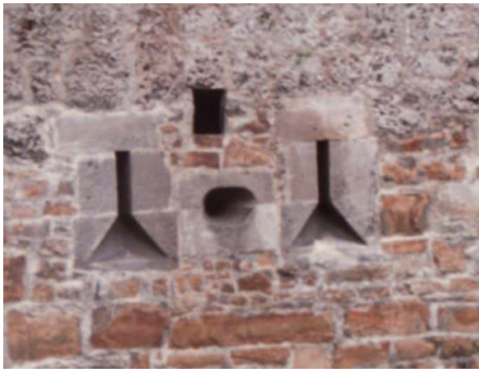
Schaufelscharte der württembergischen Festung Kirchheim (Teck). In der mittleren Ebene des Rondells Augusta ist ebenfalls eine Schaufelscharte erhalten. (Foto: Jörg Wöllper)
