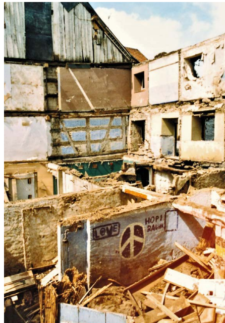
Blick auf das Erdgeschoss der Häuser 28 und 30 während des Abbruchs, rechts die erhalten gebliebene Stadtmauer nach Norden und der gemeinsame Fachwerkgiebel mit Haus Nr. 34, der demnächst abgebrochen werden wird. Die Speicher wurden nur durch Bretter abgetrennt. (Foto: Verfasser)
