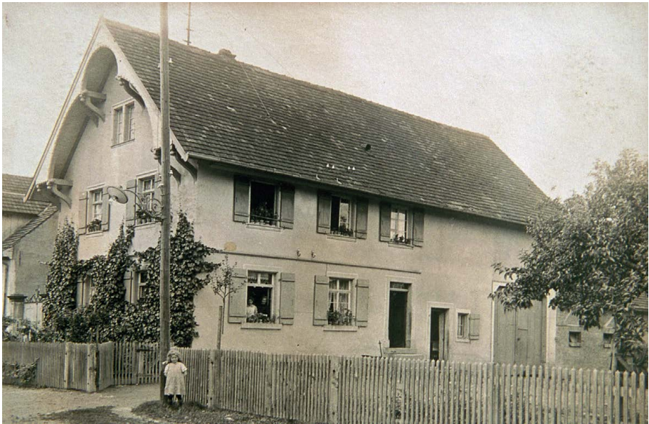
Vom Abbruch bedrohtes ehemaliges Wohnhaus Zur Sonne und Ökonomie des Reichstagsabgeordneten Carl Diez, Jakobstr. 5, erbaut 1871 (Foto: Familie Diez)
