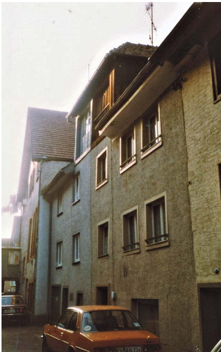
Situation Häuser Löwengasse 30 und 32. Zwei von vier barocken Häusern, die wohl durch ein soziales »Wohnungsprogramm« der Stadt errichtet wurden. (Foto: Verfasser)
