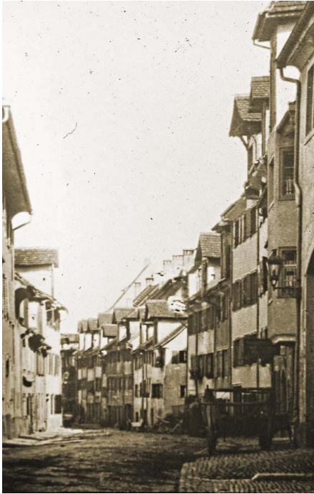
Blick vom Ende der Seestraße nach Osten um 1890. Fast jedes Haus besitzt die charakteristische Aufzugsgaube im Dach. (Foto: Stadtarchiv Radolfzell)
