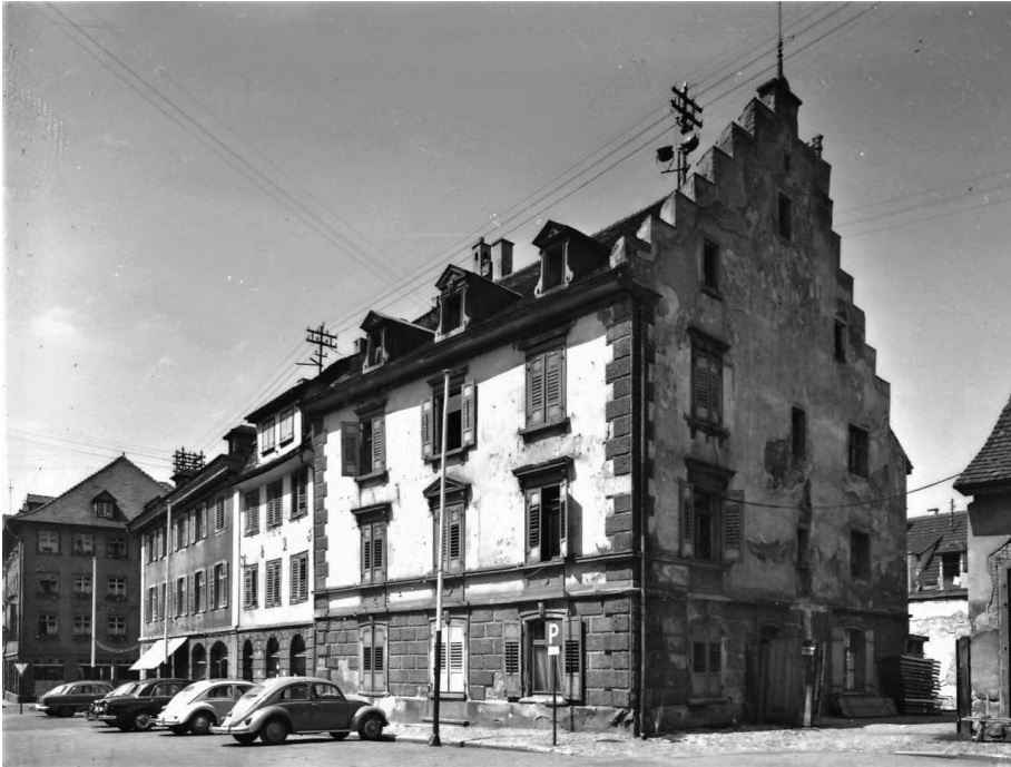
Marktplatz mit dem für den Sparkassen-Neubau 1956/57 abgebrochenen, abwechslungsreichen Ensemble aus Mansarddach (Nr. 3), daneben Haus Nr. 5 mit neoklassizistischem Tür- und Fensterdekor sowie der markante Staffelgiebel, der den Rücksprung der Bauflecht unterstreicht. (Foto: Archiv Sutter-Stadler)
