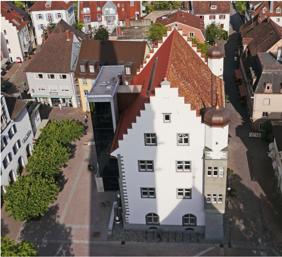
Mit der Instandsetzung und Nutzung als öffentliche Bibliothek wurde das sanierte Österreichische Schloßchen zum weithin anerkannten Vorzeigeobjekt. (Foto: Verfasser)
