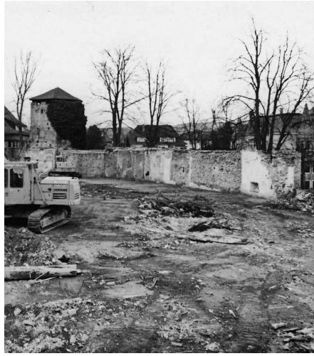
Situation nach Abbruch der Gebäude auf dem »Hölle«-Areal: Noch steht neben dem Höllturm in voller Länge die Stadtmauer, die dann widerrechtlich auf der halben Länge abgebrochen wurde. (Foto: B. Liedl)
