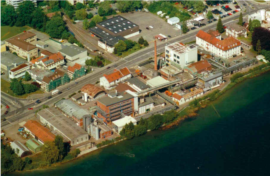
Konstanz, Degussa-Areal (ab 1990 Great Lakes), um 2000. Das strukturell in das 19. Jh. zurückreichende Industrieareal war bis zum weitgehenden Abbruch 2008 geprägt von Erweiterungen der 1920er–1980er Jahre. (Foto: Stadt Konstanz, Untere Denkmalbehörde)
