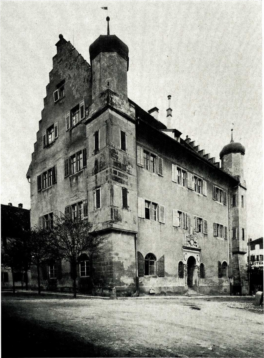
Das Österreichische Schlößchen vor der Renovierung von 1912/15 mit den verkleinerten Fenstern an den Türmen
