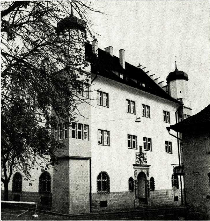
Südfront mit Hauptportal nach der Renovation
