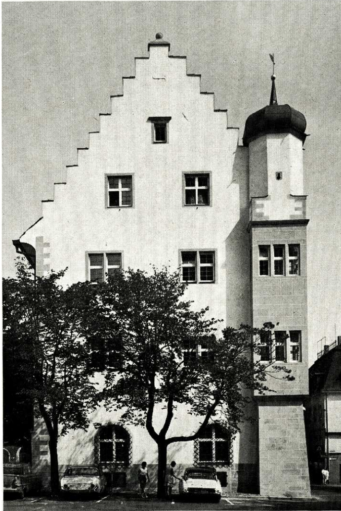
Westturm und Westgiebel nach der Renovation
