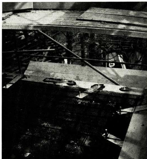
Neue Betondecke und Verankerung der Ecktürmchen oberhalb des Schaftes
