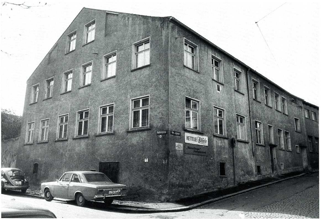
Nach der behelfsmäßigen Wiederinstandsetzung des im Zweiten Weltkrieg zerstörten Gebäudes, Zustand von 1945/46–1985. (StA Ulm, Neg. Nr. 13a–14–74)
